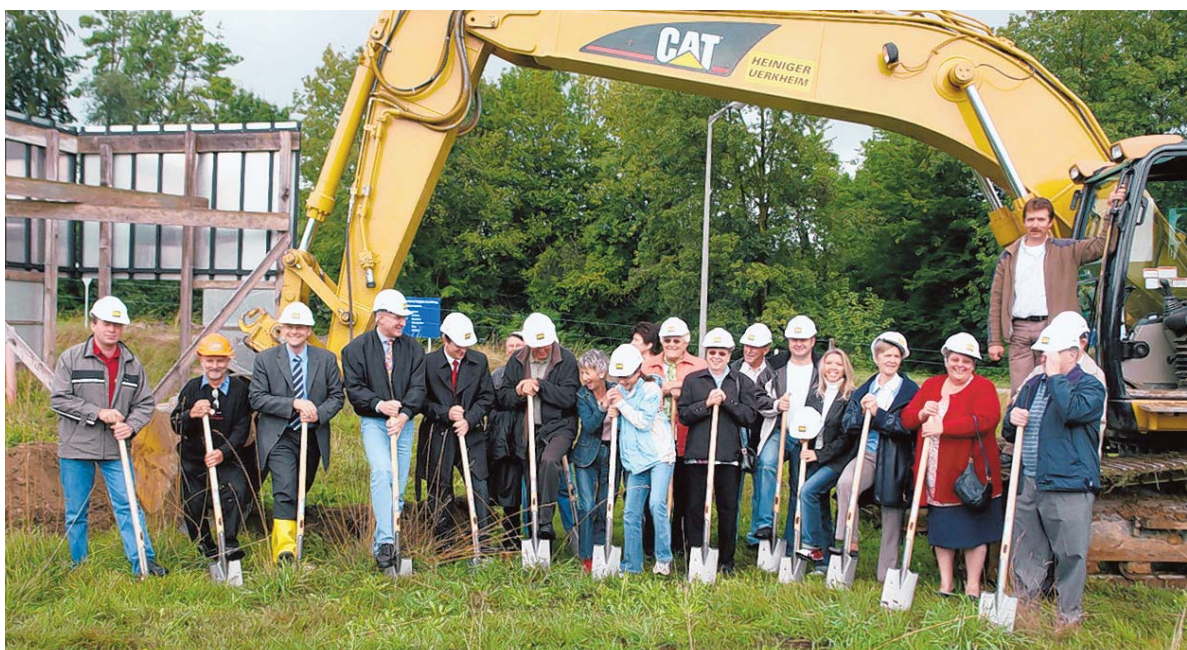
Erfolgreicher Spatenstich: Die ersten beiden Mehrfamilienhäuser der Minerige-Wohnüberbauung Jurapark in Wildegg können gebaut werden.
